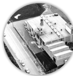
Foundry Development Razvoj ljevaonice
